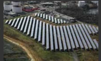
Une autre installation de Brownfield, située à Kingston, au Massachusetts, a été modernisée pour être alimentée par un système d'énergie solaire. Le système génère assez d'électricité pour que la consommation totale d'électricité soit nette zéro.
